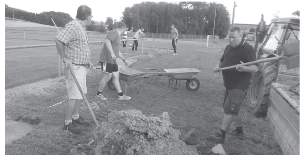
Verschiedene Helfer bei der mehrtägigen Erstellung des Ballfangzauns.
